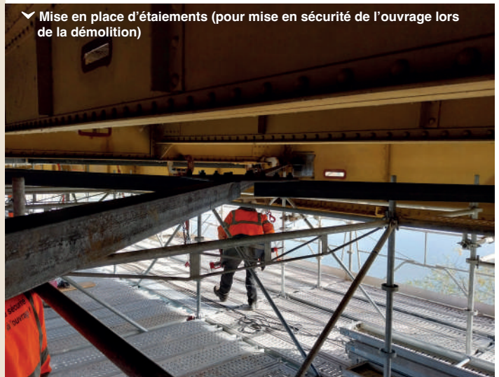
^ Mise en place des échafaudages sur les travées rive droite et centrale
