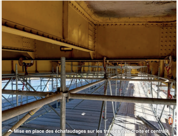
^ Mise en place d'étaisements (pour mise en sécurité de l'ouvrage lors de la démolition)
