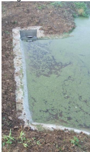
Pelle installée et fermée. Plan d'eau à sa cote normale.
