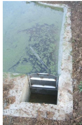
Pelle opérationnelle. Les lentilles sont évacuées
