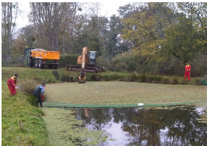
Raclage de surface et récupération au godet étanche
