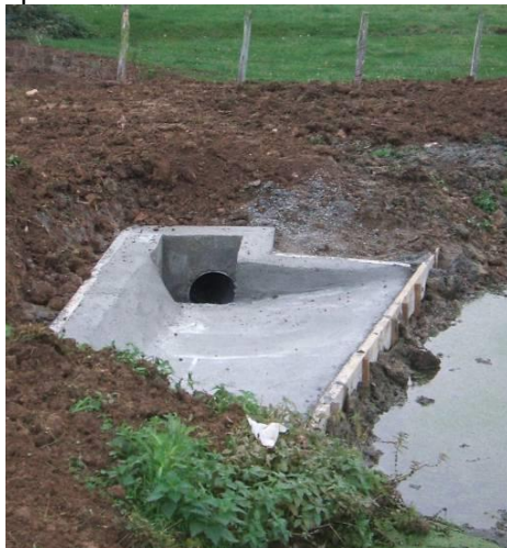
Seuil déversoir aménagé.
