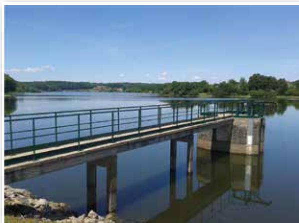
Prise d'eau dans une retenue superficielle
