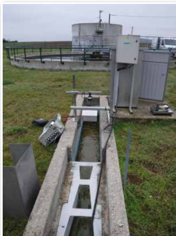
Canaux de mesure de débits en sortie de station d'épuration
