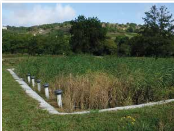
Étages de filtres plantés de roseaux
