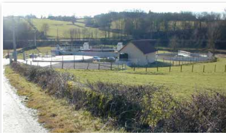
Stations d'épuration de type boues activées
