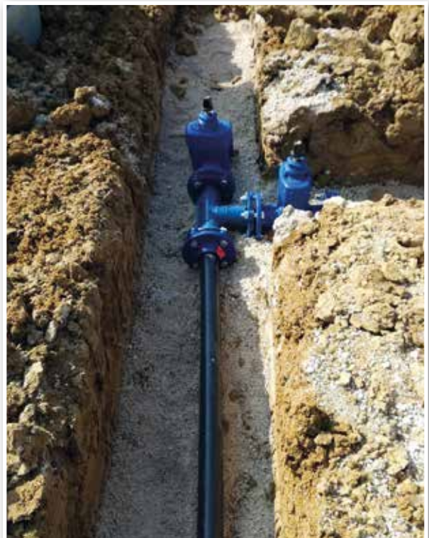
Pose de réseau neuf
