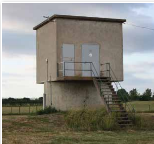
Puits de captage en nappe alluviale
