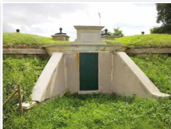
Entrée d'un réservoir semi-enterré
