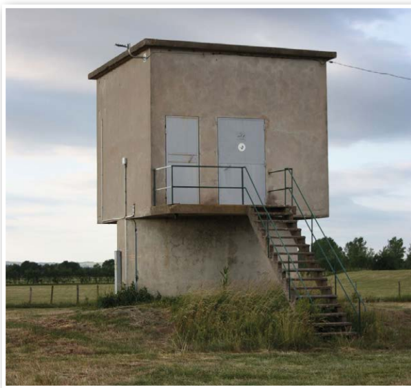
Puits de captage en nappe alluviale
