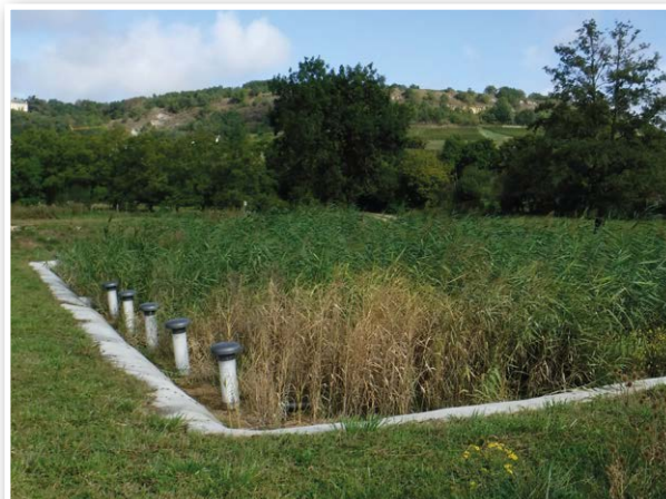
Étages de filtres plantés de roseaux
