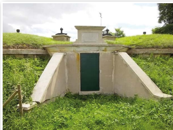
Entrée d'un réservoir semi-enterré
