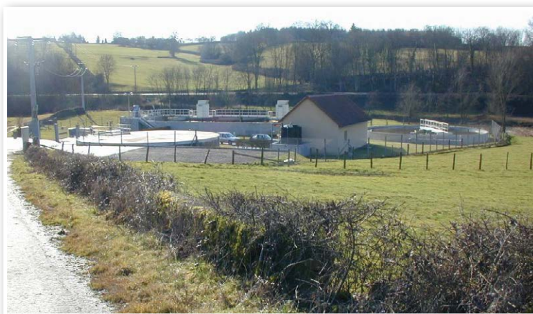
Stations d'épuration de type boues activées
