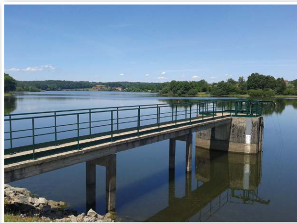
Prise d'eau dans une retenue superficielle
